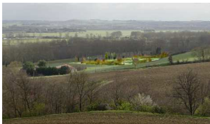
Vue après travaux depuis le chemin de ronde
